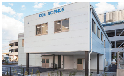
2018年に第二工場が竣工
